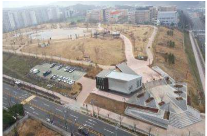
달천철장 정비 공사 전경 14)
