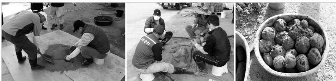
〈그림 10〉 점토 만드는 과정(모래:마사:황토 혼합→손으로 두드리려 공기층 제거→적당한 크기 만들기)
