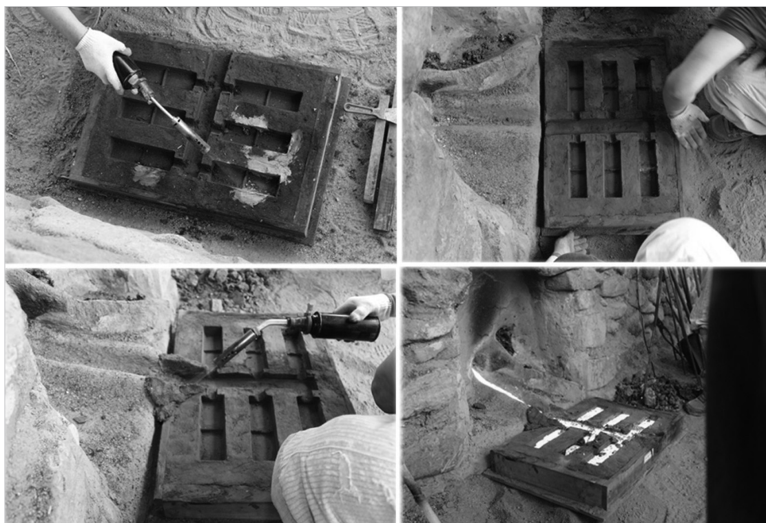
〈그림 21〉 판장쇠바탕 설치
