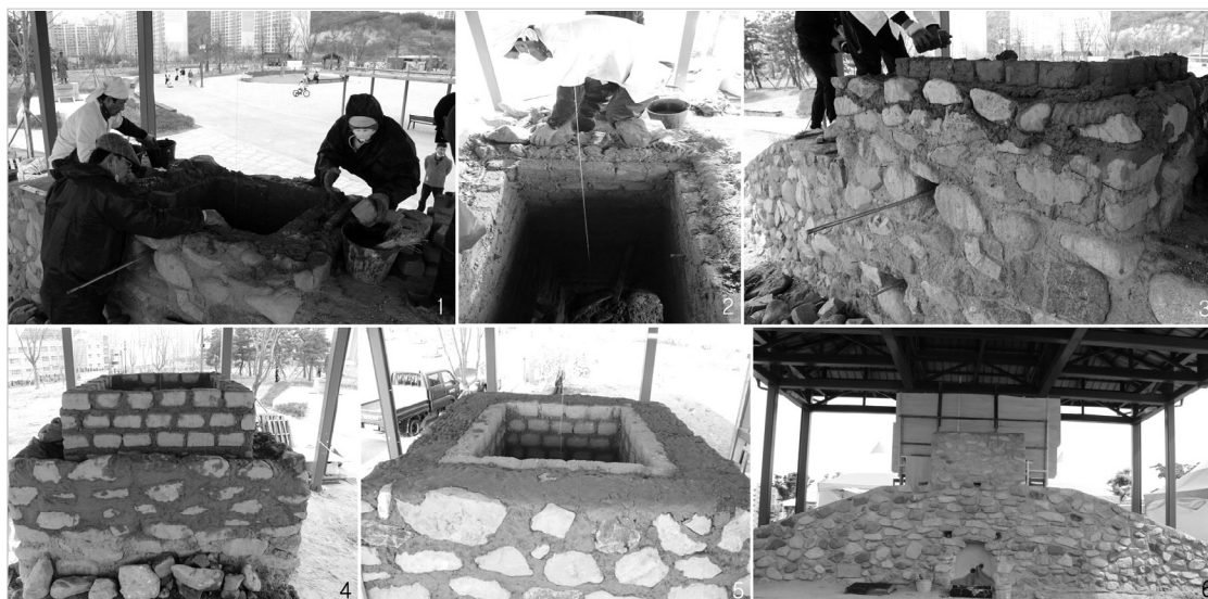
〈그림 12〉 상부 축조과정(1:황토몰칠과 점토 놓기, 2:점토 위에 석재놓기, 3:점토블록 올리기, 4:점토블록 쌓기, 5:점토블록+석재 쌓기, 6:축조 후 전경)
