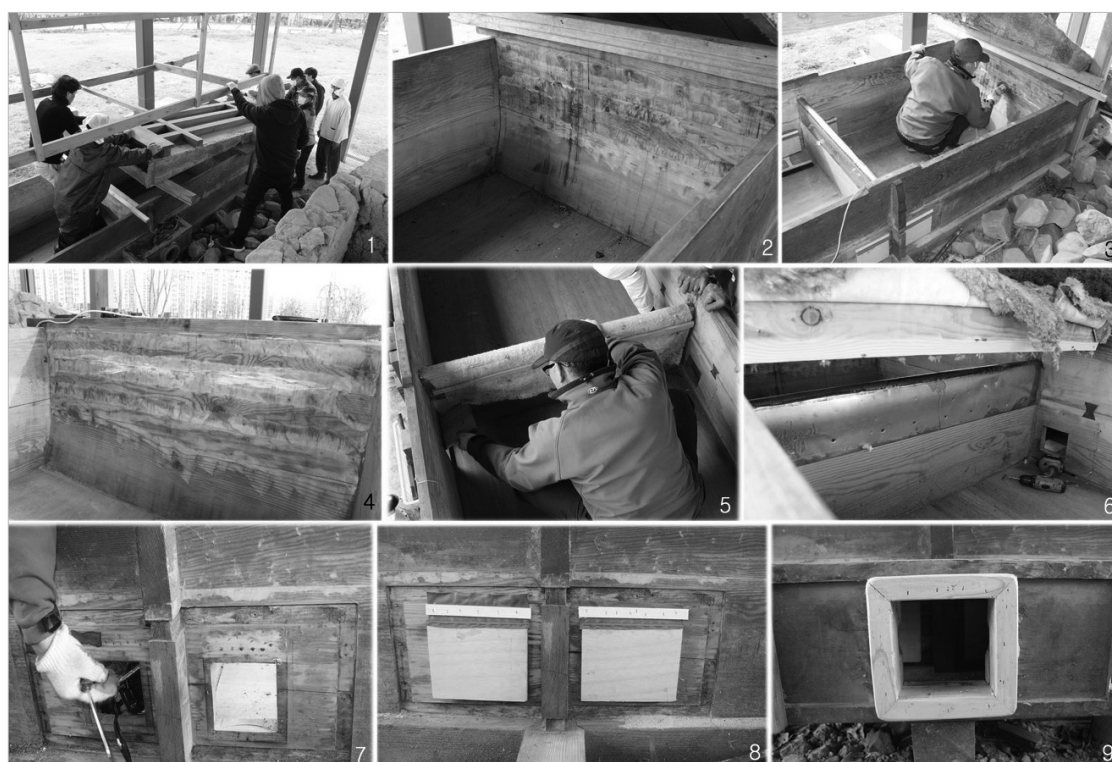
〈그림 14〉 풀무 점검과정(1:상판 들어내기, 2~4:풀무통 양단 갈아내기, 5:중앙 고정목 천 제거, 7~9:송풍구 보수)
