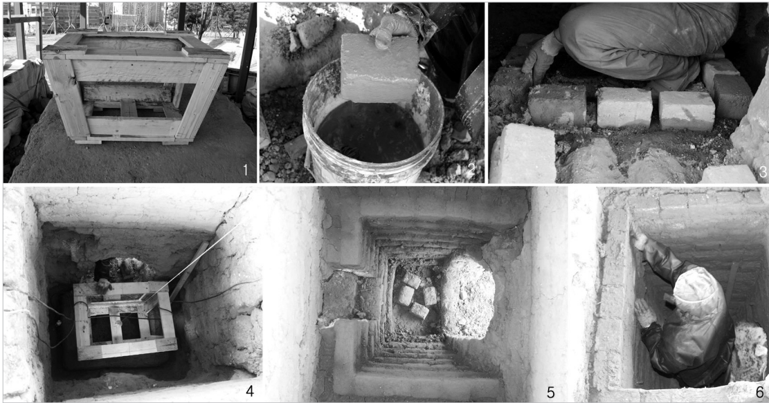
〈그림 11〉 하부 내벽 보수(1:가마 모형틀, 2:블록 황토물칠, 3:바닥에 블록깔기, 4:모형을 놓고 블록 쌓기, 5:계단식 블록 쌓기, 6:하부미장)
