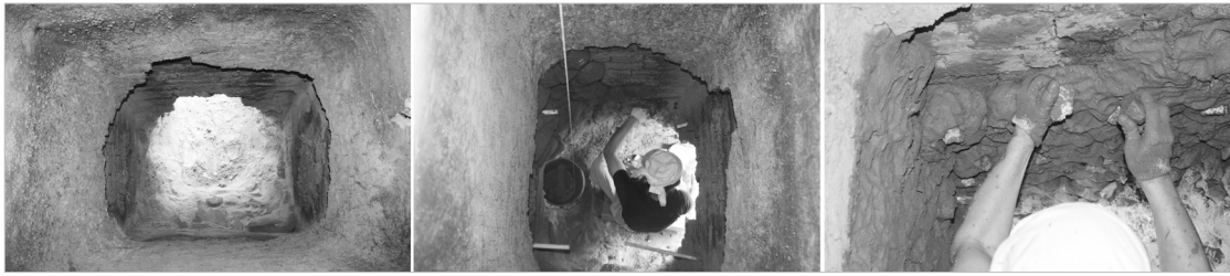
〈그림 8〉 가마 내벽 보수 과정(좌: 탈락-용융부 확인, 중: 1차 미장 점토채움, 우: 점토채움 세부)
