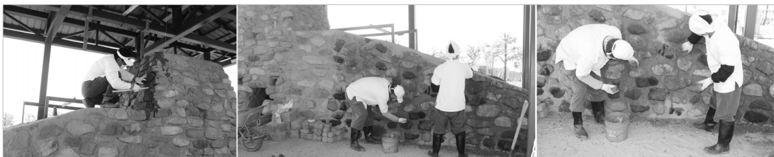
〈그림 11〉 가마 외벽 보수
