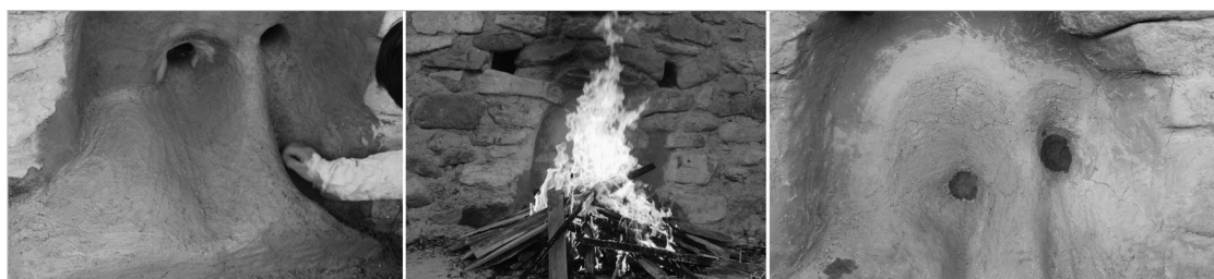
〈그림 19〉 앞창 축조과정-2 (좌: 출탕구와 배재구 축조, 중: 건조, 우: 완성된 초롱구멍과 잡쇠구멍)
