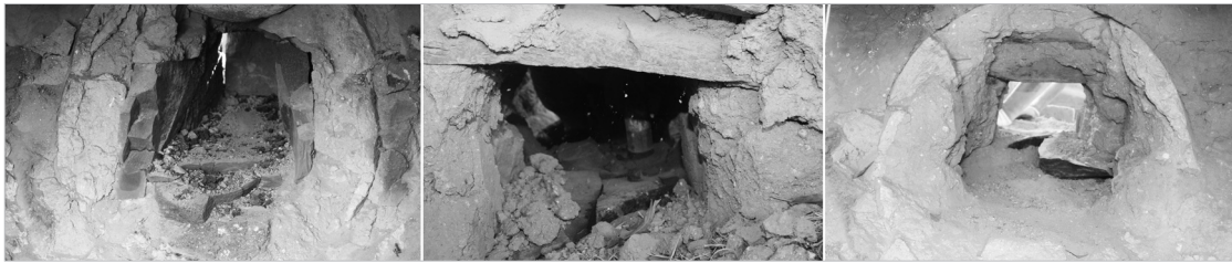
〈그림 14〉 골구멍 잔존상태 및 석재 제거 후
