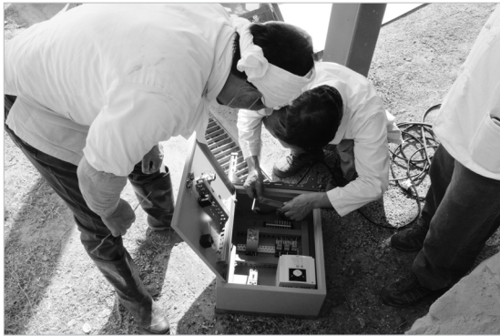
〈그림 25〉 기계 송풍기 전력량 점검
