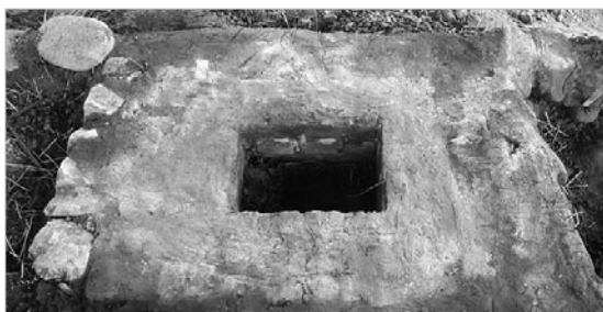
〈사진 21〉 방습시설 축조 완료
