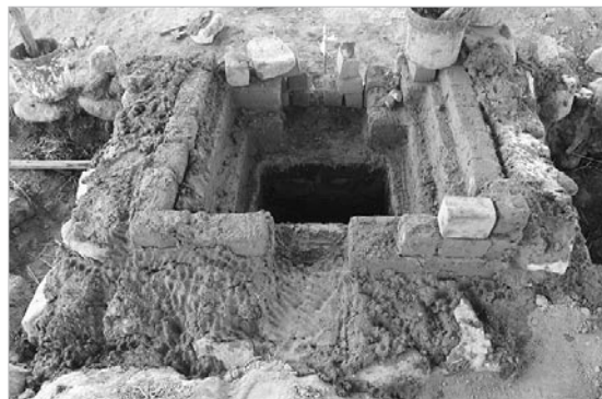
〈사진 35〉 벽체 하부 내어쌓기 모습
