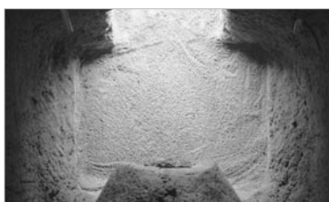
〈사진 23〉 방습시설(굽은 모래)
