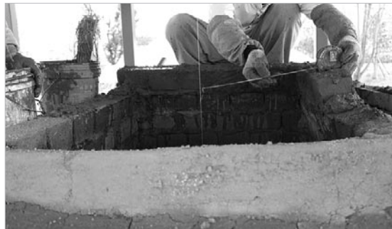
〈사진 39〉 상부 좁아지는 내경 측정
