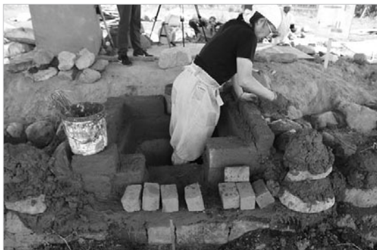
〈사진 34〉 내면 황토블록 쌓기
