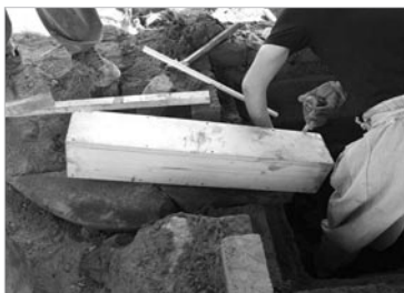
〈사진 58〉 골구멍 목재를 설치
