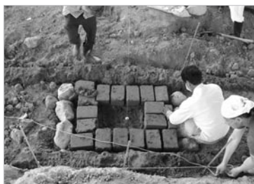
〈사진 16〉 방습시설 최하단 축조
