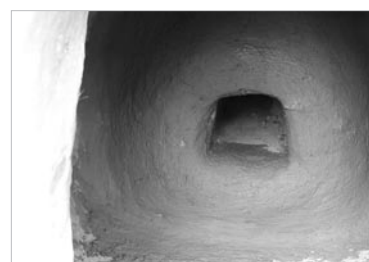
〈사진 48〉 골구멍 보수
