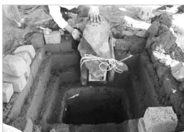
〈사진 60〉 목재를 주변 판석 설치(2)
