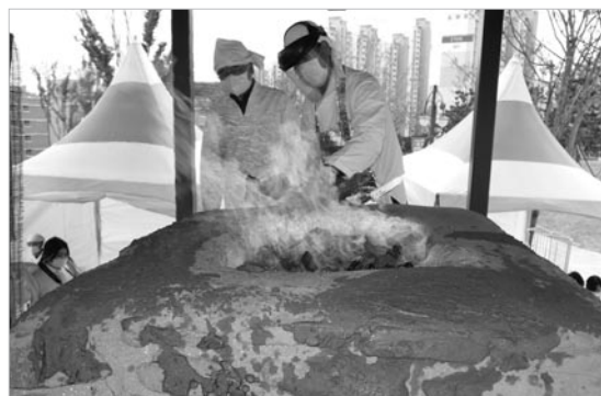
〈사진 99〉 가마 상단부 보수
