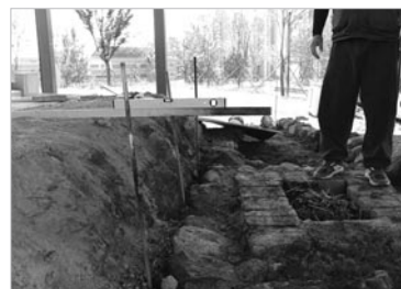
〈사진 17〉 골구멍과 방습시설 높이 측정
