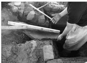
〈사진 57〉 골구멍 설치
